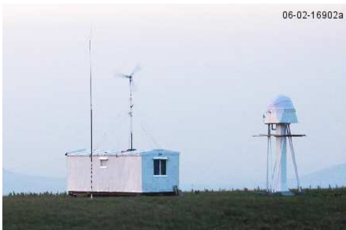
Рис. 1: Общий вид астроклиматического пункта на г. Шатджатмаз с юго-западного направления. Телескоп установлен на бетонном столбе, купол поддерживается металлической вышкой. Ветрогенератор установлен на 4.5 м мачте на крыше вагона, в котором смонтирована система электропитания. На этой же мачте расположены датчики температуры и влажности и анемометр. На переднем плане 10 м мачта грозозащиты.
